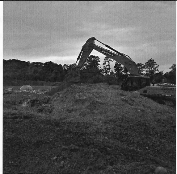
Fotografía 2: Maquinaria reforzando el pretil de la zanja N°6
