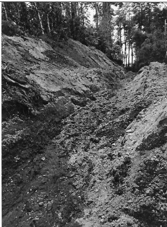
Fotografía 5: Área afectada por el derrame de lodo cercana a la quebrada.
