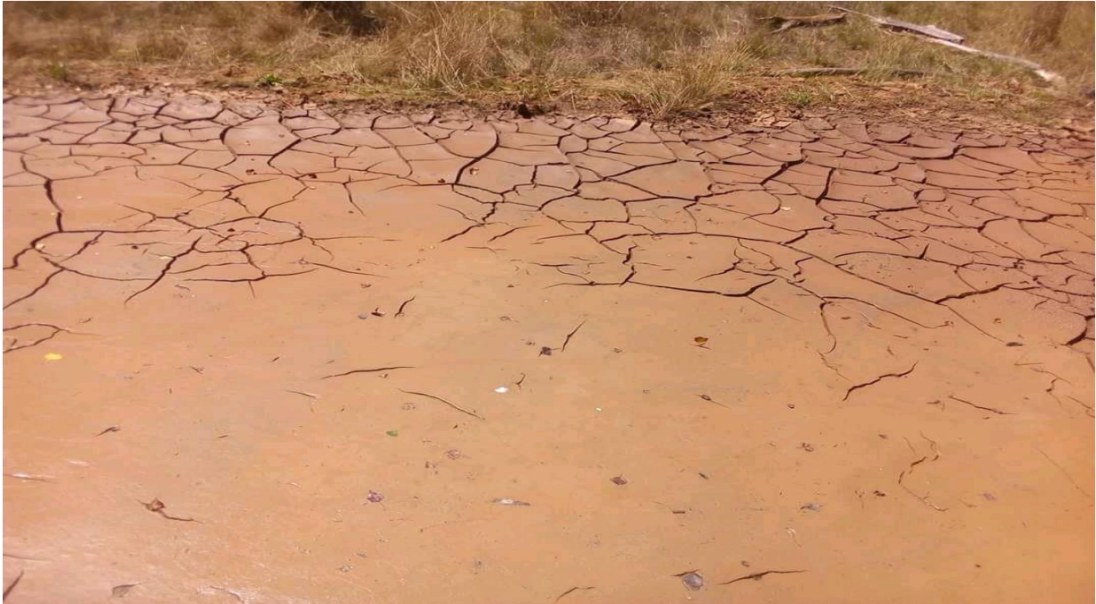
Acumulación de sedimento en estero y predios aledaños, arrastrados por lluvias de enero de 2021.
