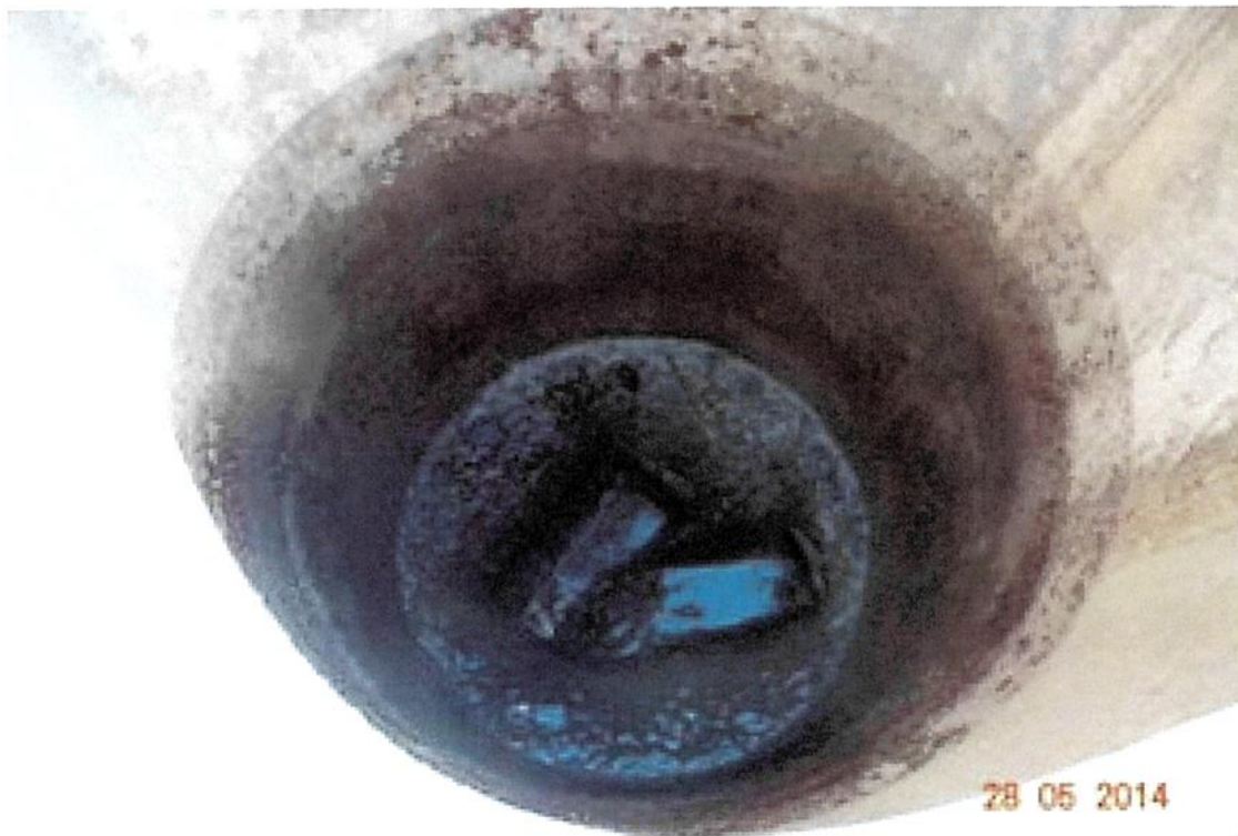
Fotografía 2: Cámara de registro, observándose 2 canaletas de hormigón.
