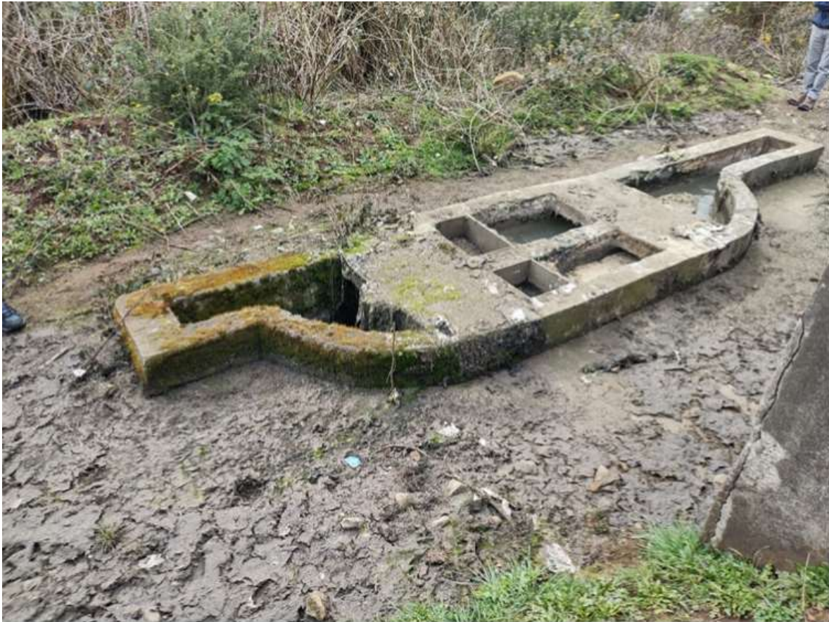
Figura 5. Imágenes de la estructura “filtro”
