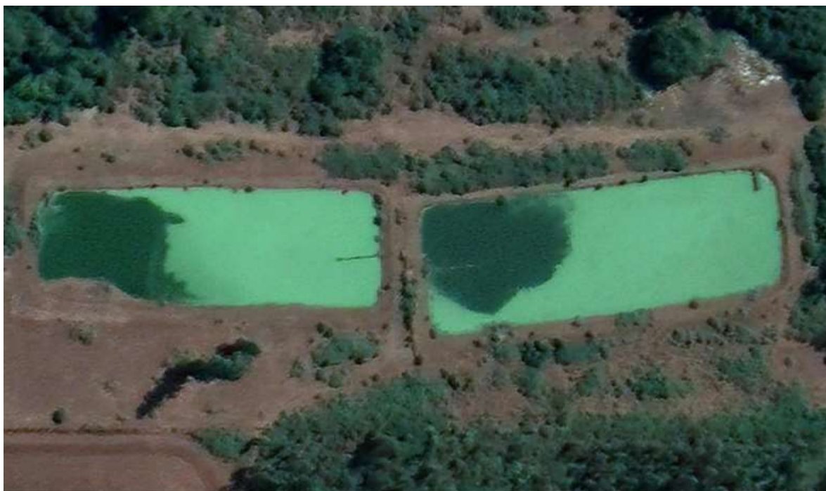
Figura 2: Disposición de las piscinas de decantación
