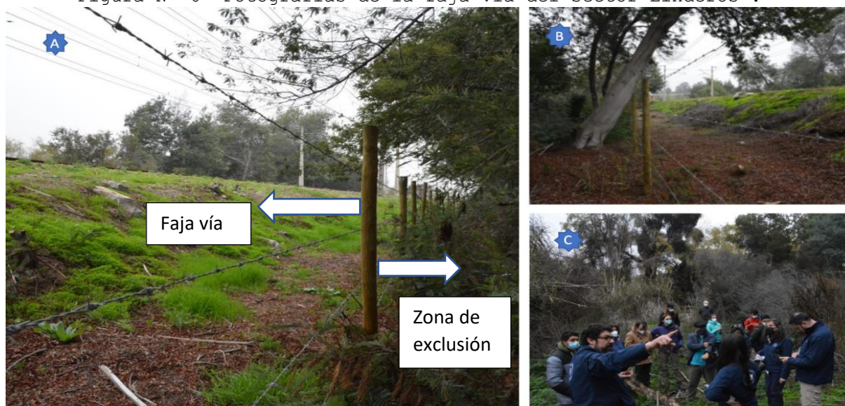
Figura N° 6 "Fotografías de la faja vía del sector Linderos".
