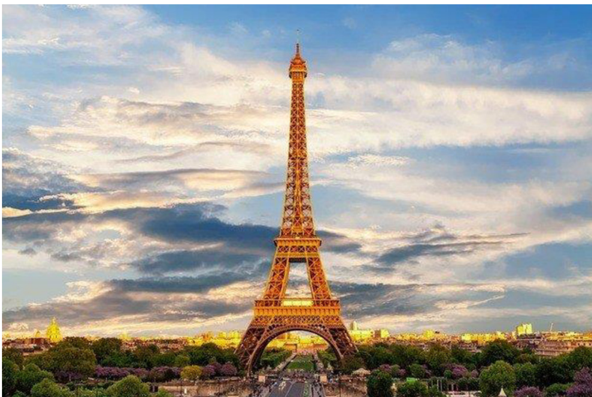
Imagen: Fotografía que da cuenta de la altura de la Torre Eiffel en la ciudad de París-Francia, que cuenta con una altura cercana a los 320 mts de altura (Sólo 54 metros más que las torres que el concesionario pretende construir).
