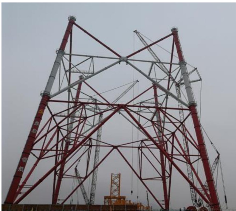
Imagen: Foto referencial de operación de montaje de las estructuras de suspensión, incluida en el Capítulo 1 del EIA.
