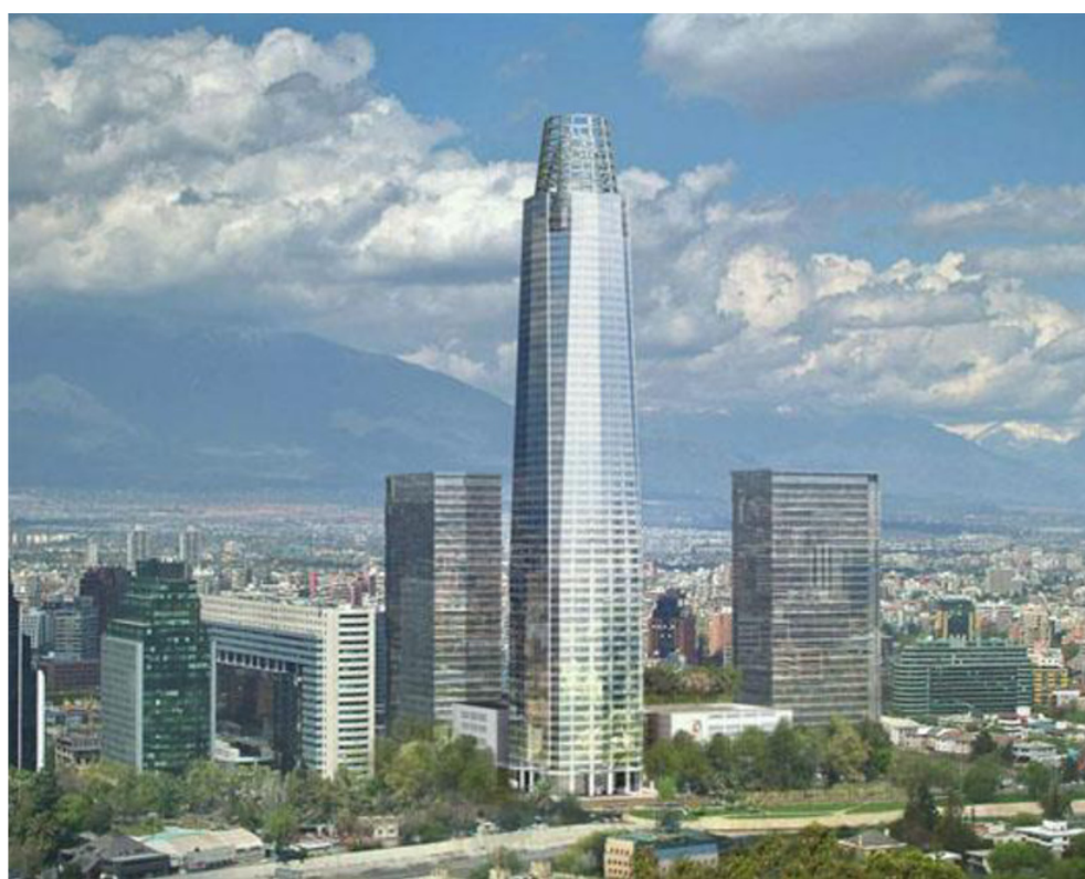
Imagen: Fotografía que da cuenta de la altura del Edificio Costanera Center en la ciudad de Santiago, que cuenta con una altura cercana a los 297 mts de altura (Sólo 30 metros más que las torres que el concesionario pretende construir).
