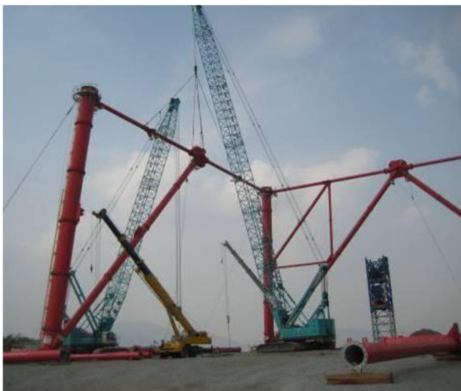
Imagen: Foto referencial de operación de montaje de las estructuras de suspensión, incluida en el Capítulo 1 del EIA.
