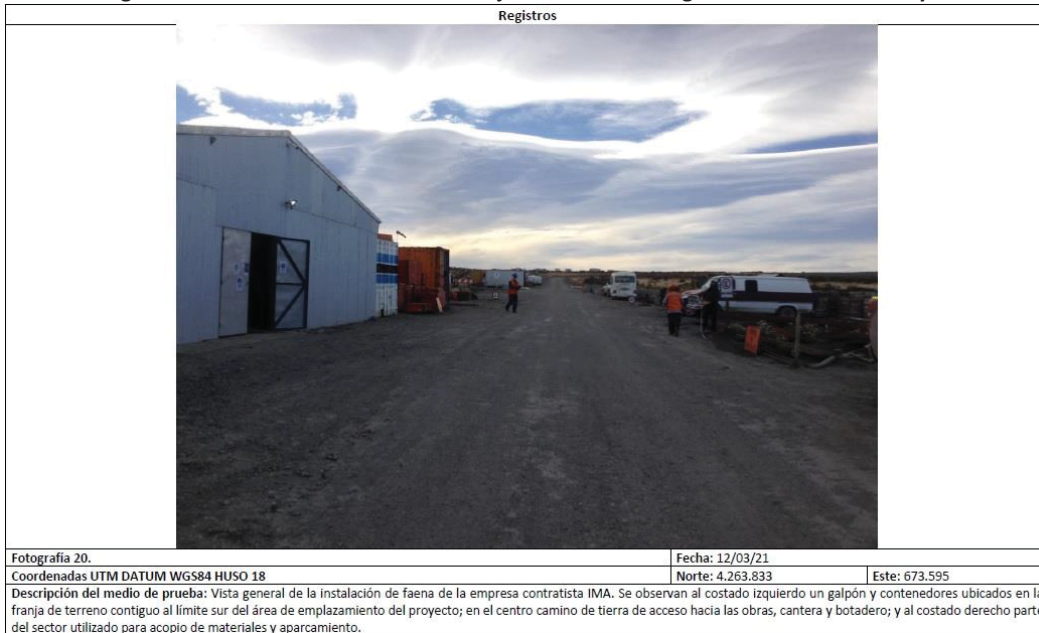
Imagen 1: Contenedores ubicados en franja de terreno contiguo al límite sur del Proyecto
