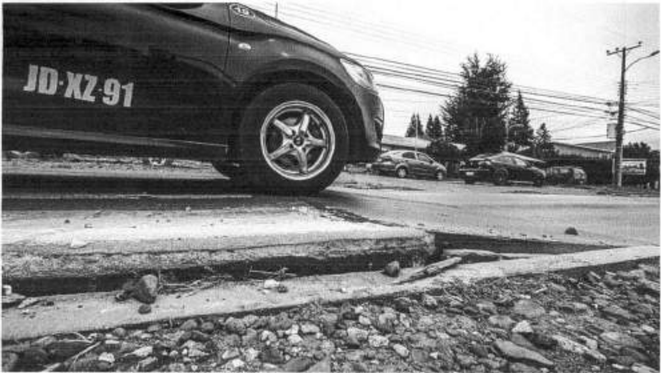
Calle Mardones con calle 6 de Noviembre.
