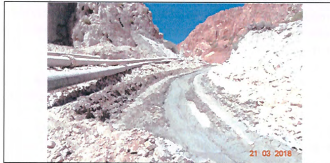
Fotografía N° 3 – Recorrido lamas en Quebrada Variante 2
