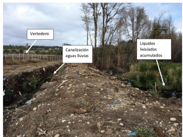
Figura 27: Detalle de zona de acumulación de lixiviados en zona circundante en la parte oeste del VID. Fuente: IFA (DFZ-2019-482-X-RCA-IA) (fs. 4406)
