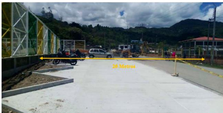
Fotografía No.2 - Inicialmente se tenía una separación entre cierros de 13,2 metros actualmente tiene una distancia promedio de 20 metros.
