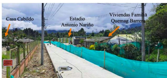
Fotografía No.2 – Calle 1 Sur entre Carreras 2 y Puente sobre el río Quinchoa - Noviembre 2022
