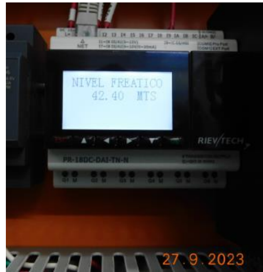
Fotografía N° 8: Registro de nivel dinámico del agua subterránea en pozo PR.
