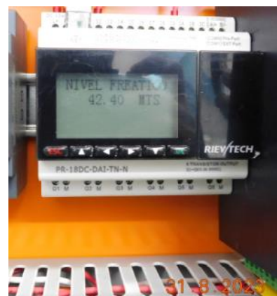
Fotografía N° 6: Registro de nivel dinámico del agua subterránea en pozo PR.
