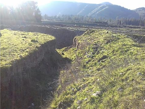
Oficinas LTM Inicio Zanja
